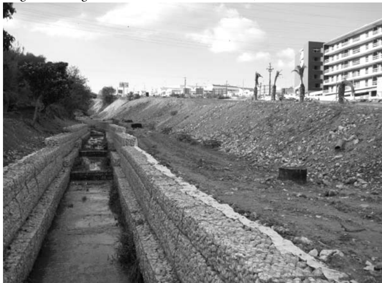
Figura 13 – Regularização do troço subaéreo da R a de Sacavém (gabiões e degraus de amortecimento de cheias). Foto de 23/11/2009.
